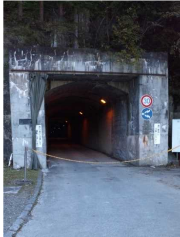
高瀬ダム奥のゲート
